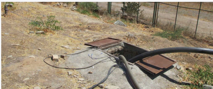
مخازن زیر زمینی برای استفاده از آب باران ذخیره شده
